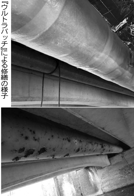
修繕前の水管橋
