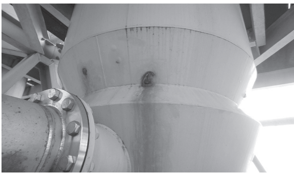
施工前の脱硫塔
