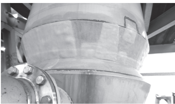
ウルトラパッチの貼付後
