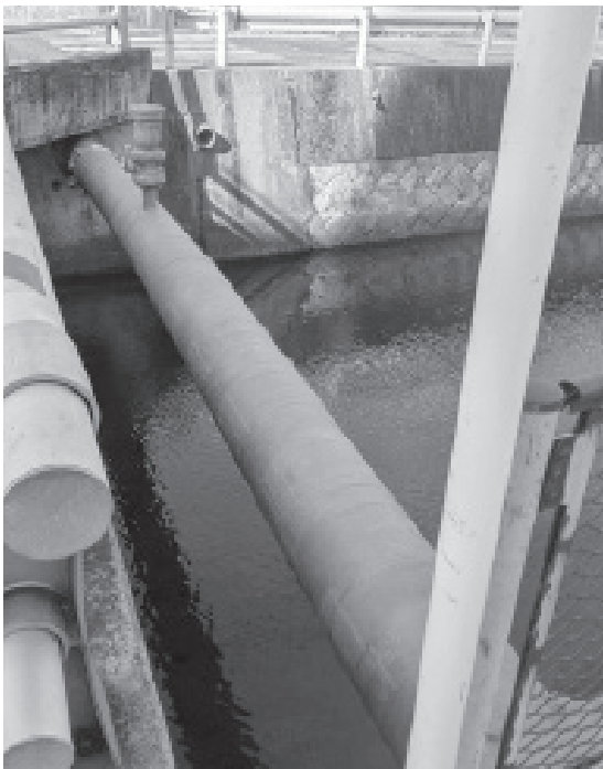
重防食・延命化が期待できる「ウルトラワックステープ」で施工した水管橋
