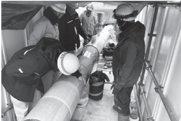
「ウルトラパッチ」による劣化部の補強の様子
